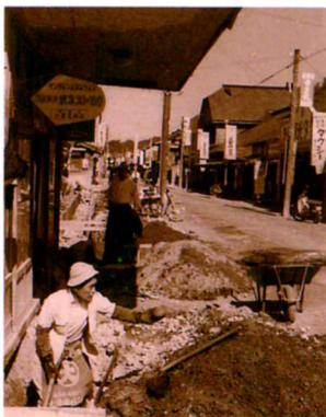
S36. 国道118号改良
