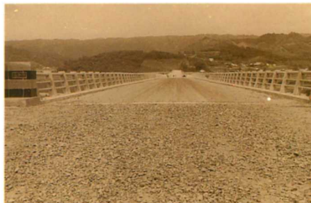
S 39. 矢祭橋竣工
