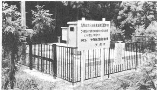
④第5配水池
