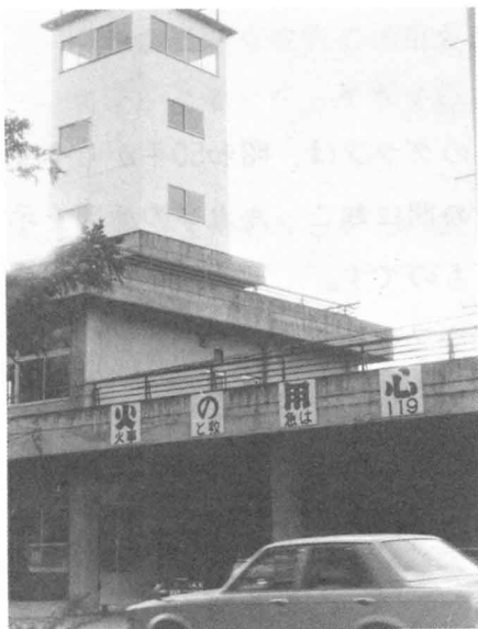
〈棚倉消防署塙矢祭消防分署〉
