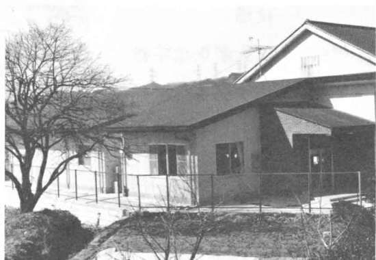
▲ ようち 町立石井幼稚園 〈大字中石井字 ごでん 御殿川原5番地〉
