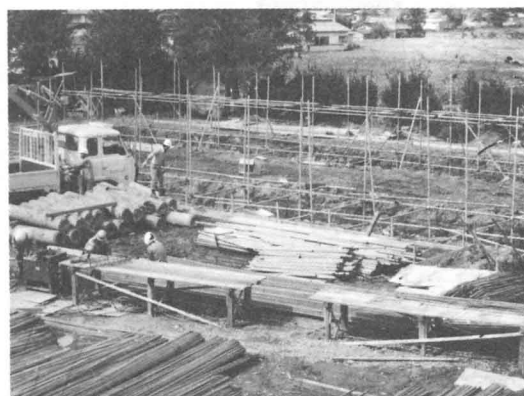
▲校舎の建築工事が始められる。 (基礎工事)
