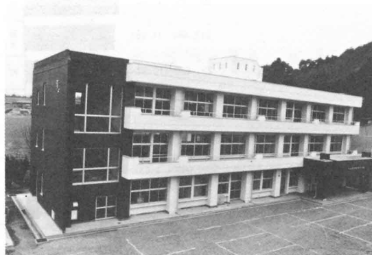
▲第1期工事の完成 (昭57.3)
