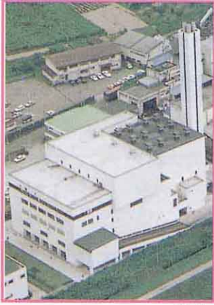
① せいそう工場の全景
