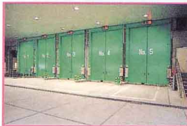
① プラットホーム
