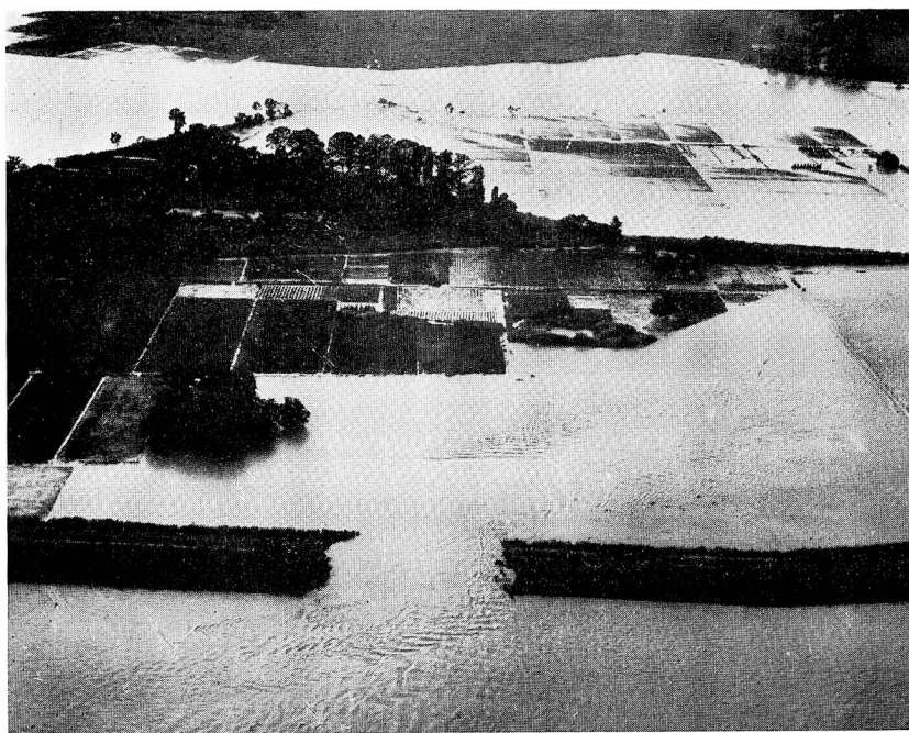
昭和31年7月17日 鶴沼川の堤防決潰溢流の様態
