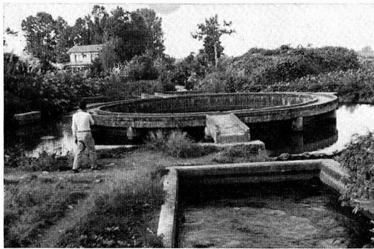
大川用水堰の円形分水装置、中央に噴きあげて、 4水路に平均に分ける
