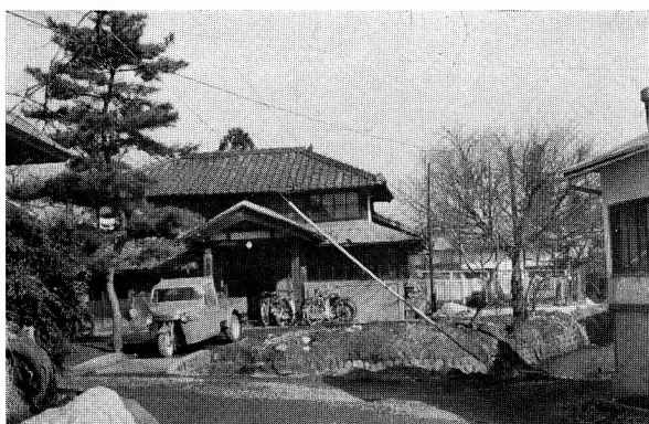
中荒井旧御倉跡の旧館の内村役場跡
