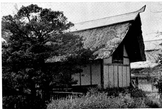
金屋旧肝煎宅の裏ちゅうもん造り（中門造り）
