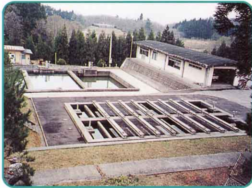
▲ 浄水場 (二小地区)
