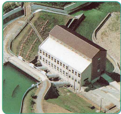
▲ 日橋川発電所
