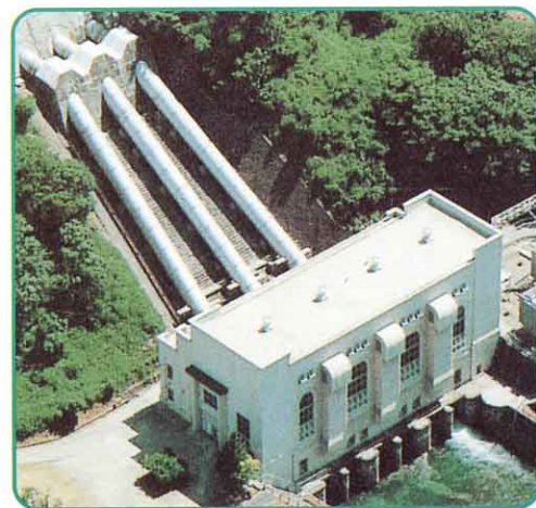
▲ 猪苗代第三発電所
