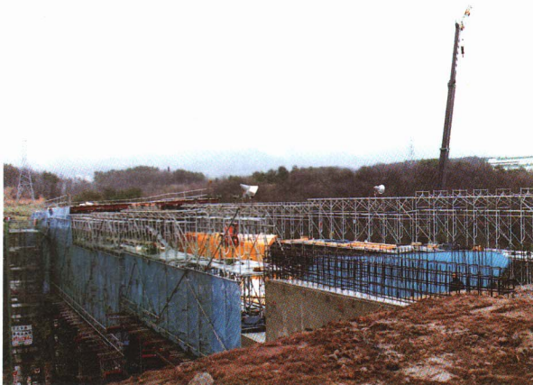
日橋川にかける新しい橋の工事
