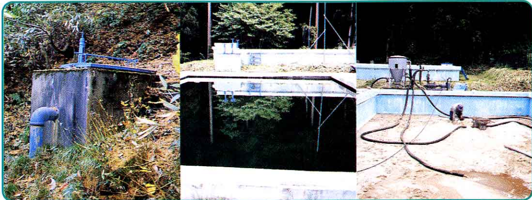
↑ 桂沢水源地 かつらざわすいげんち
