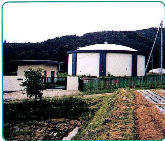
↑ 見祢配水池 みねはいすいち
