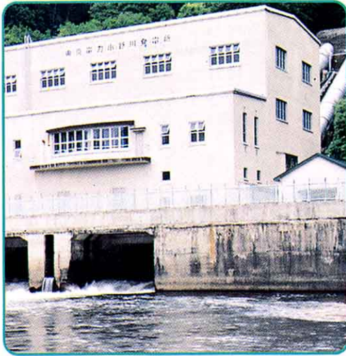
④ 小野川発電所
