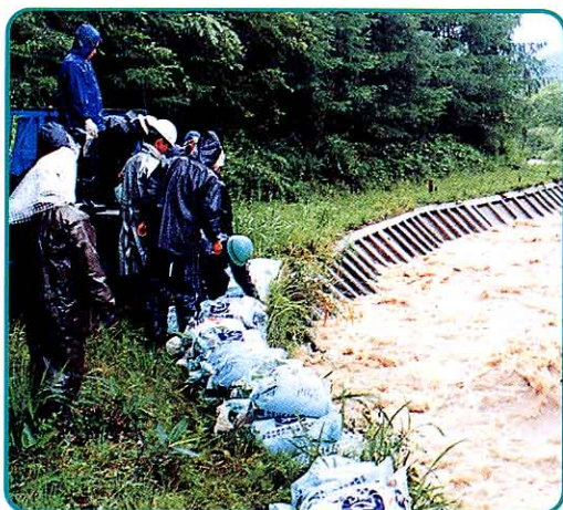
土のうを積む消防だん（小倉川）
