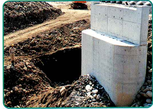
➡ 新大倉川橋工事
