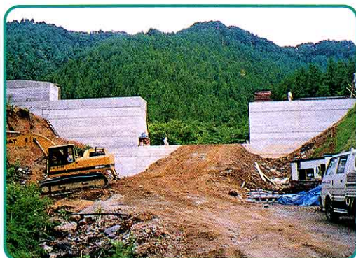
➡ さぼうダム工事
