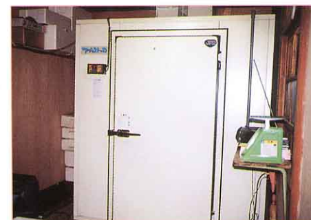
①しゅうかくしたアスパラを冷 ひ やしておく予冷庫
