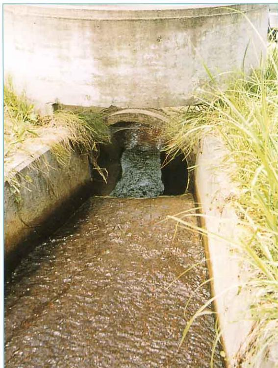
⑦現在、雄国地区に流れ込んだ水は高さをたもちらながら、水田に流れます。水田をだんにしたり、コンクリートの水路でだんを作ったりして、高さに差をつけ、水が流れやすくなるように工夫しています。
