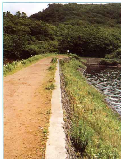
①改修された百間土手
