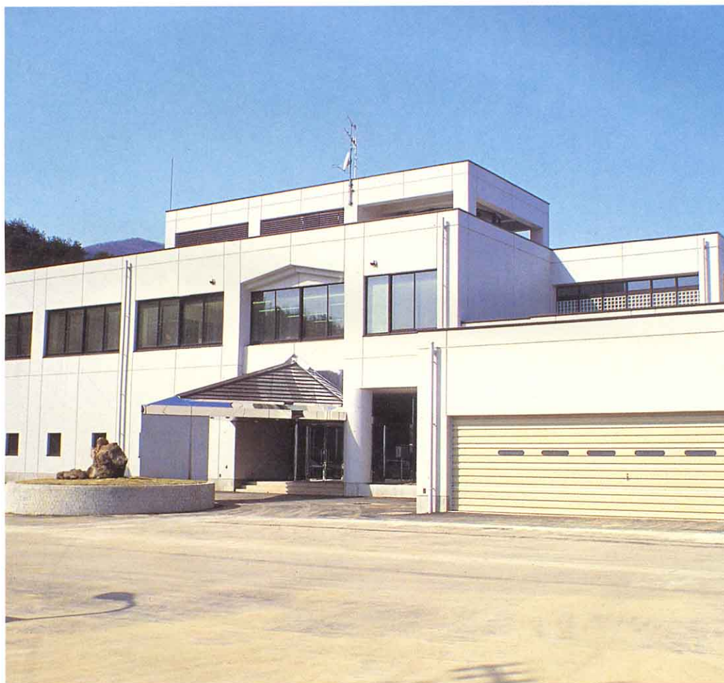
浄水場（ き たかたち ほうすいどうようすいきょうきぎょうだん 喜多方地方水道用水供給企業団）
