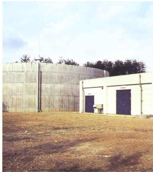
じゅすい ち 受水池
