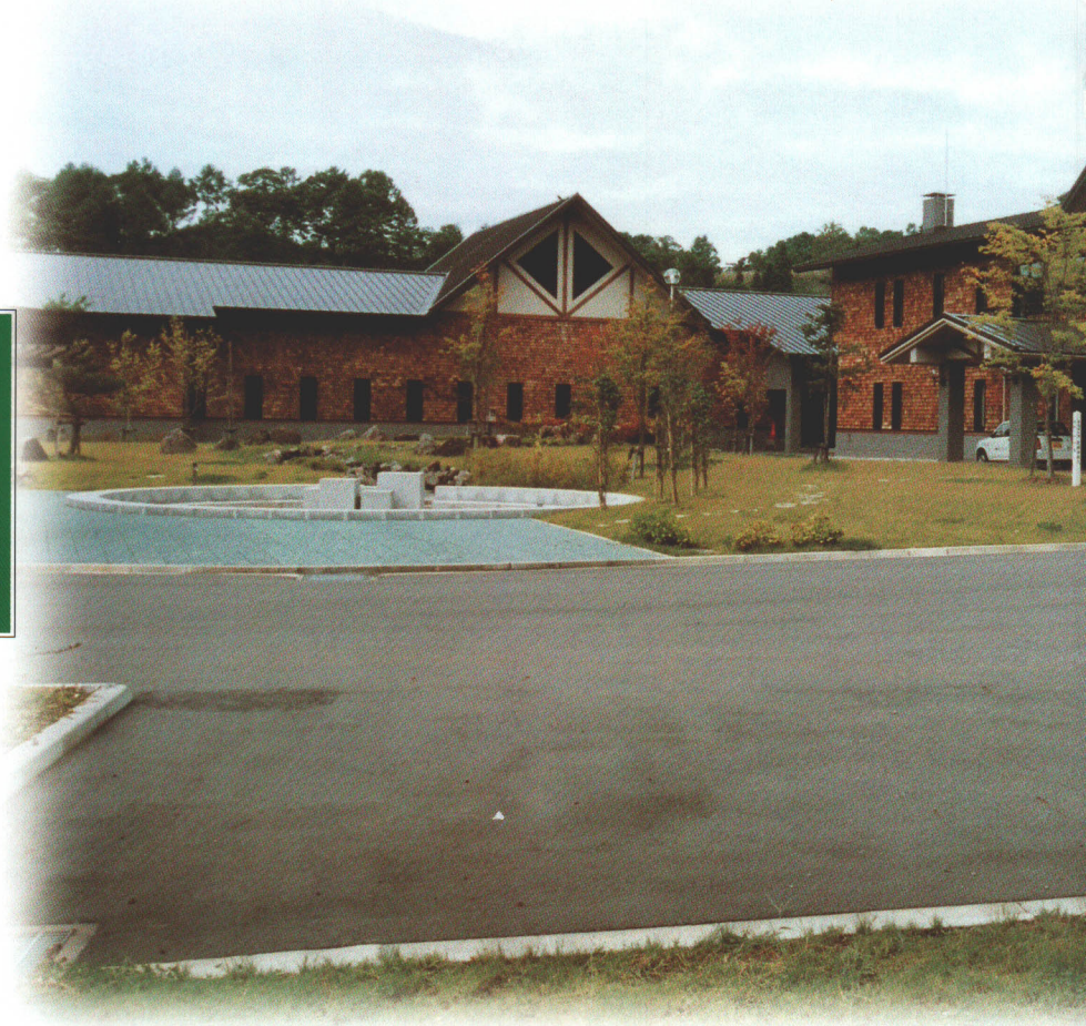
▲裏磐梯浄化センター。ホテルを思わせるような建物で水の浄化を行っている。
