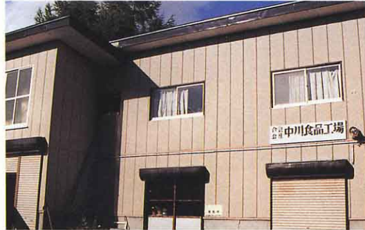
外から見た工場の様子
