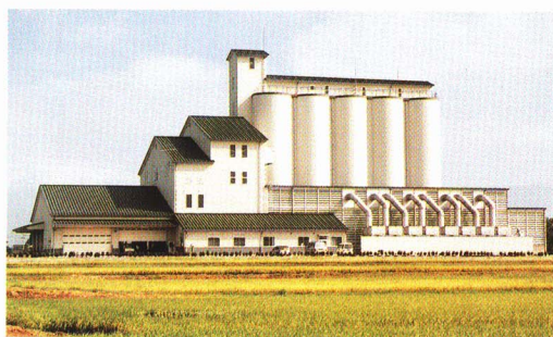
カントリーエレベーター
