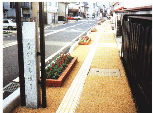
ほどう 水たまりのできないカラー歩道
