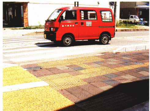
しかくしょうがいしゃゆうどう 視覚障害者誘導ブロック
