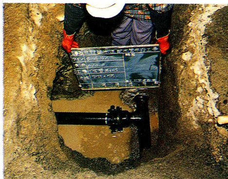
▼水道をひく工事
