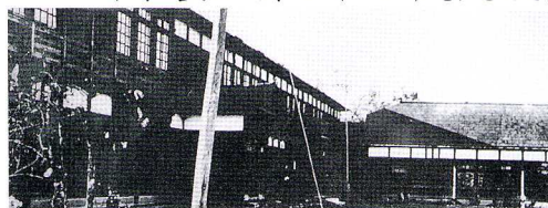
新郷尋常高等小学校 (明治30年建築)
