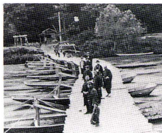
西羽賀の舟橋 （大正14年完成）
