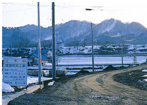
▲道路工事のようす（荻野～西海枝間）
