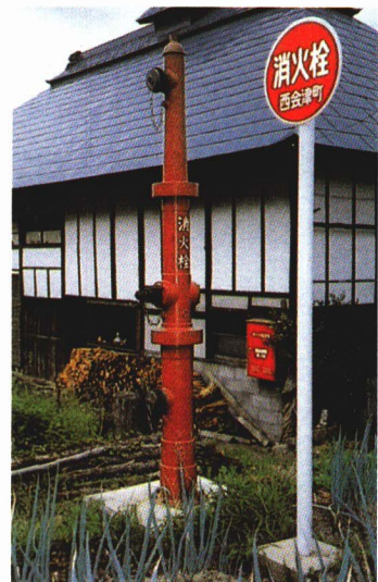
しょうか せん あおざか ちく ▲消防栓 (青坂地区)
