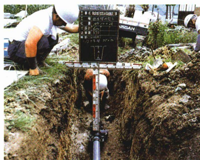
水をひく工事
