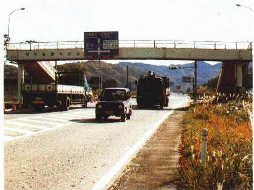
▲国道49号西会津バイパス
