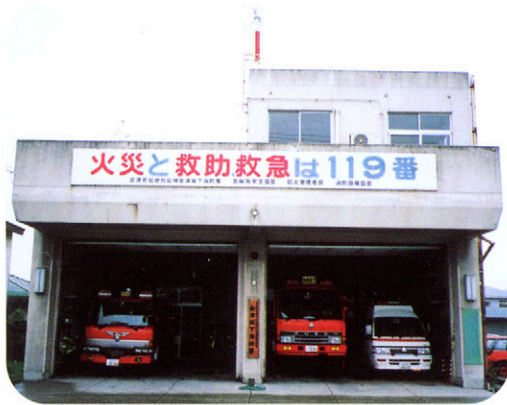
会津若松地方広域市町村圏整備組合 会津坂下消防署
