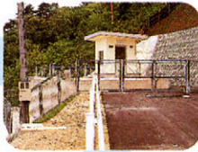
かこうじょう 高寺配水場
