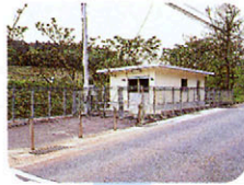
とうでら 塔寺ポンプ場
