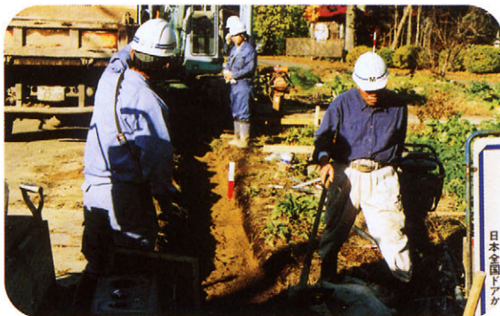
水道管を交かんしている
