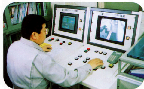
富川ぜきのコントローラー (阿賀川土地改良区コントロール室)
