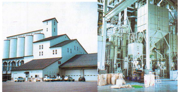
カントリーエレベーター
