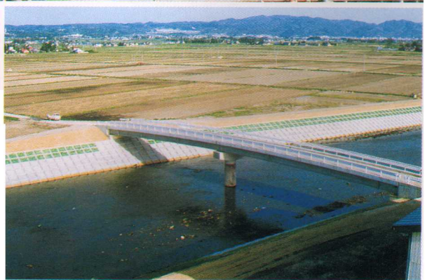
せせなぎ 改修した瀬川(平成6年)
