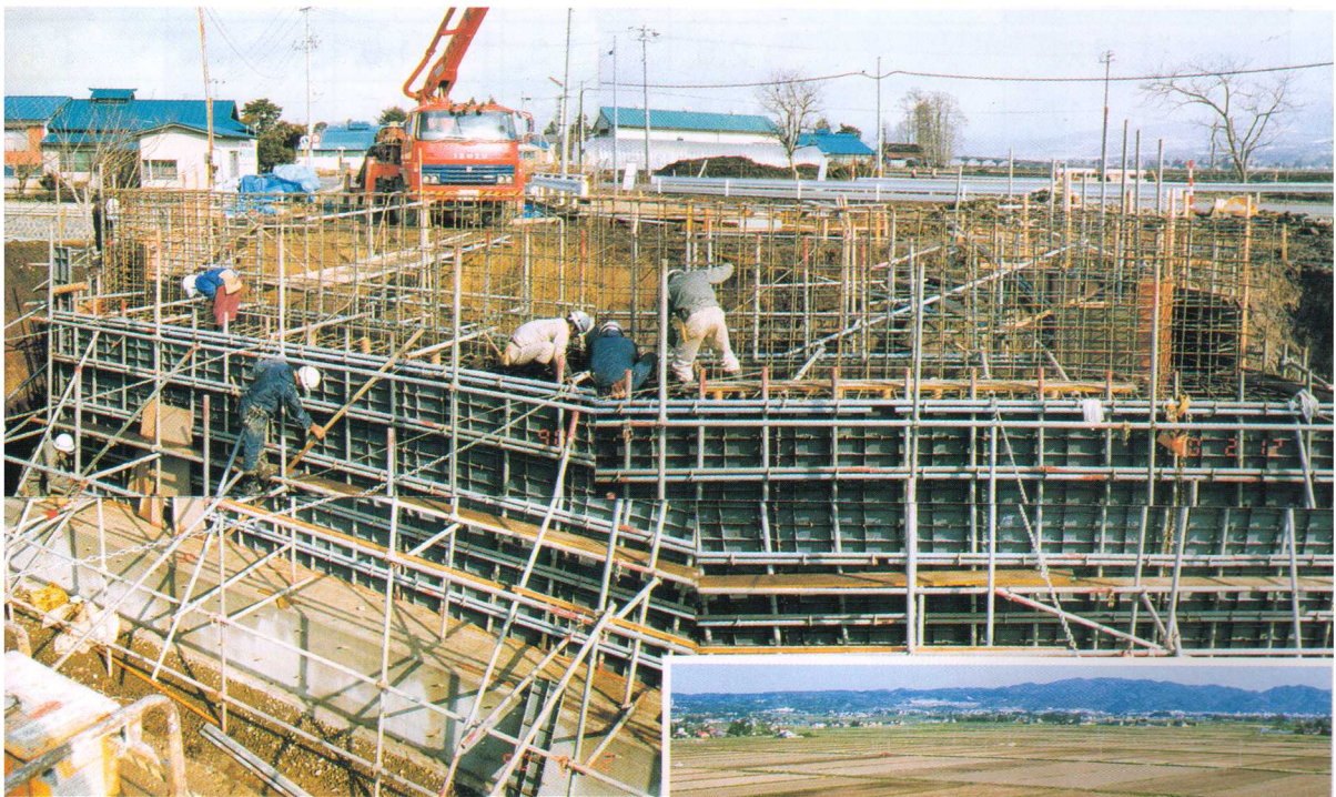
(県道橋)工事(平成2年)
