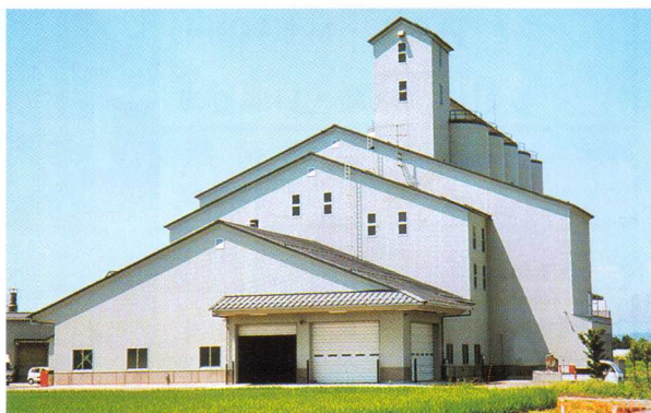
カントリーエレベーター
