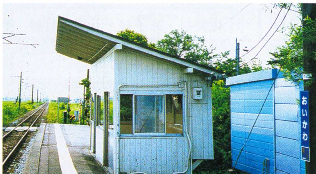
今の筧川駅 1934年(昭和9年)に筧川駅が開設されました。
