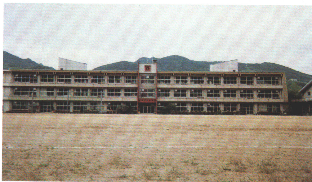
▲正面から見た柳津小学校
