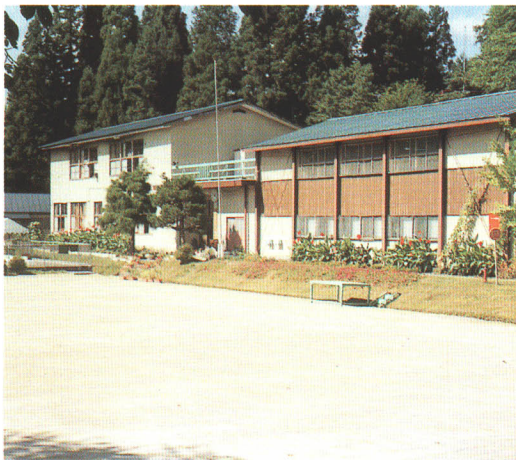
▲久保田小学校の校舎・体育館
