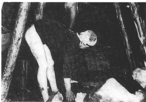
▲トンネル工事
