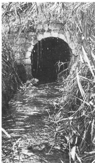
▲中ノ川からのトンネル
