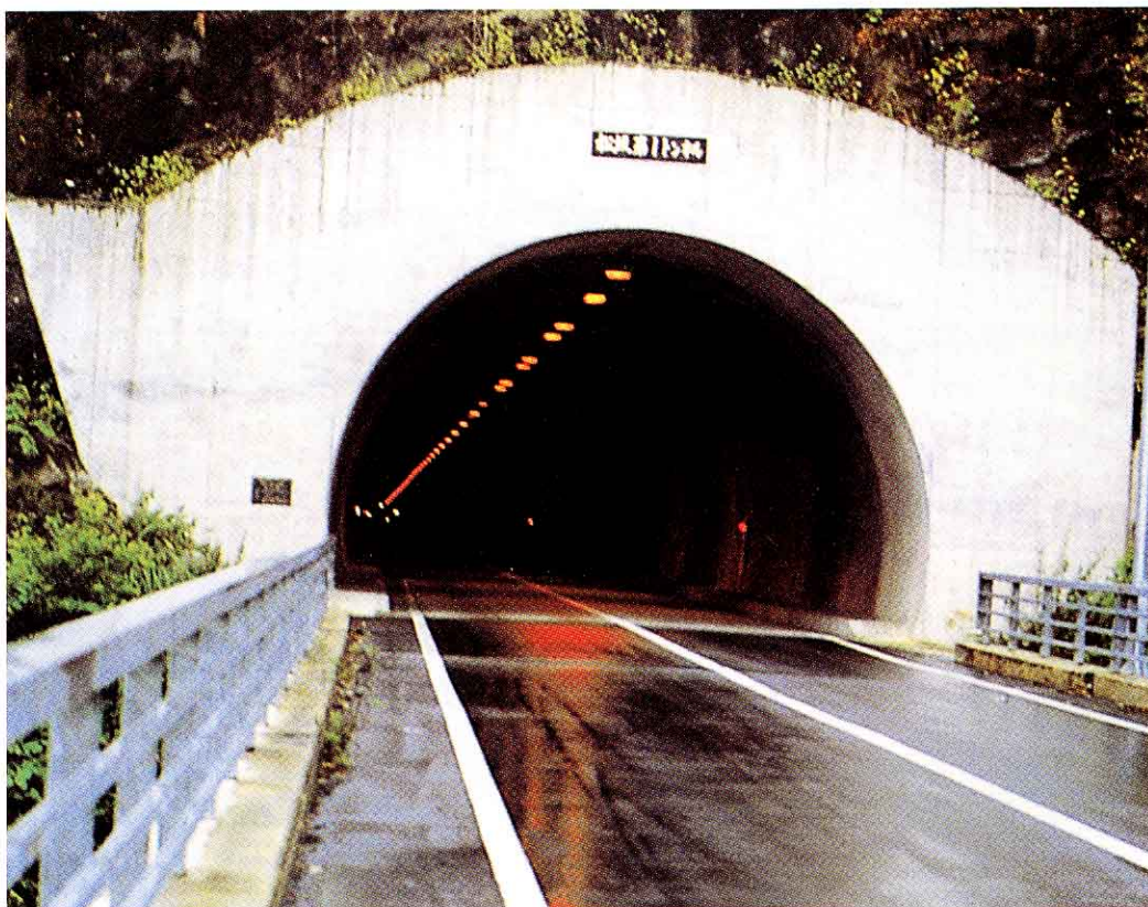
▲新宮川ダム付近の松坂トンネル
