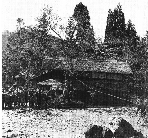
大谷地溜池堤防決壊で家財を対岸に渡す二岐の住民（昭和30年／菊地定吉氏提供）
