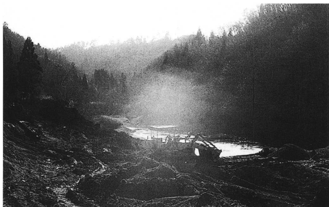
二岐ダム工事着工（昭和38年／村松孝太郎氏提供）
